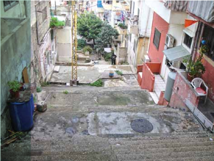
Karm El Zaitoun Project—Before
