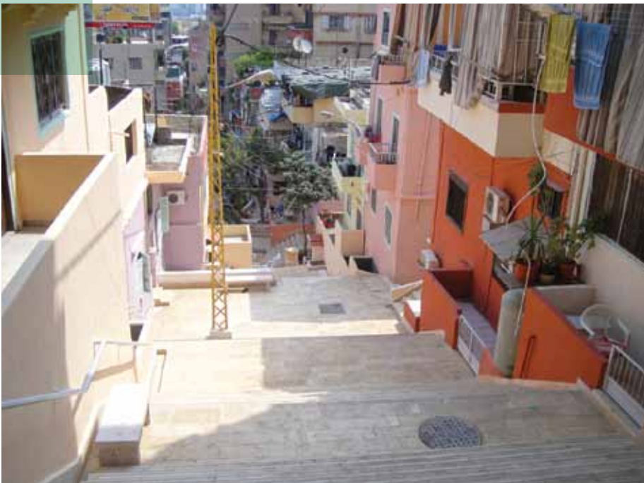
Karm El Zaitoun Project—After
